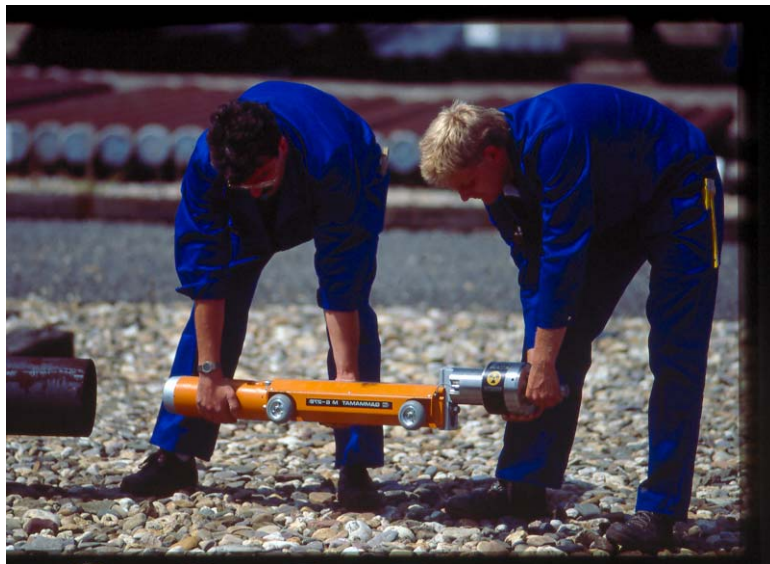
Bild 7 Installation des Molches im Rohr
