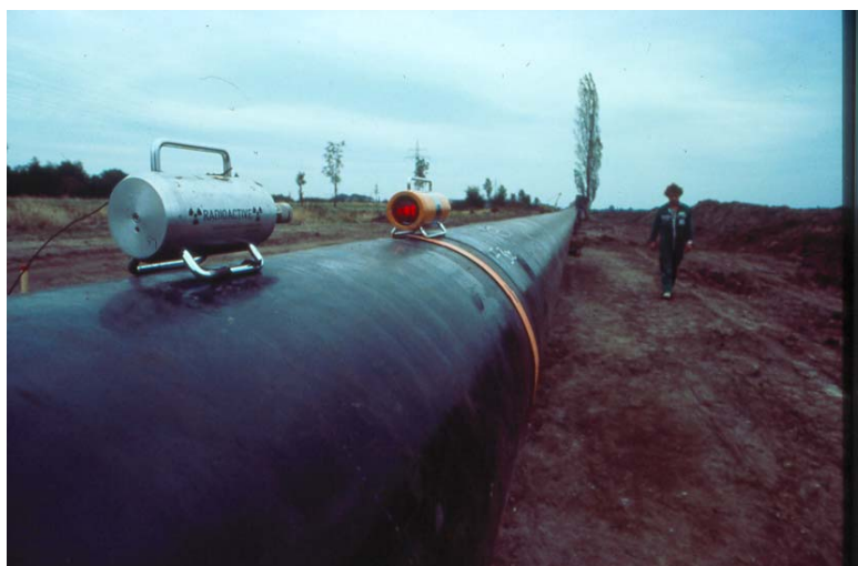
Bild 10 Positionierung des Molches
